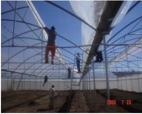
INTERNOS EN LABORES DE CONSTRUCCIÓN DE INVERNADERO
